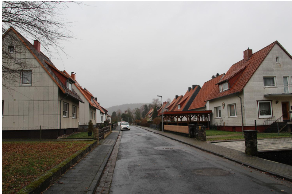
Abb. 75: Typische Bebauung an der Breslauer Straße
