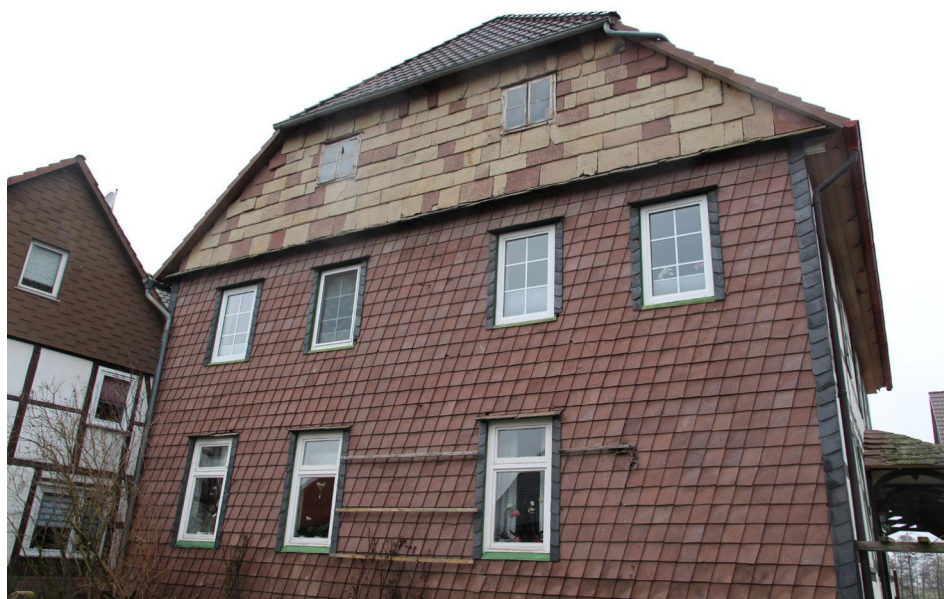
Abb. 41: Ortstypischer Behang mit Wesersandsteinplatten
