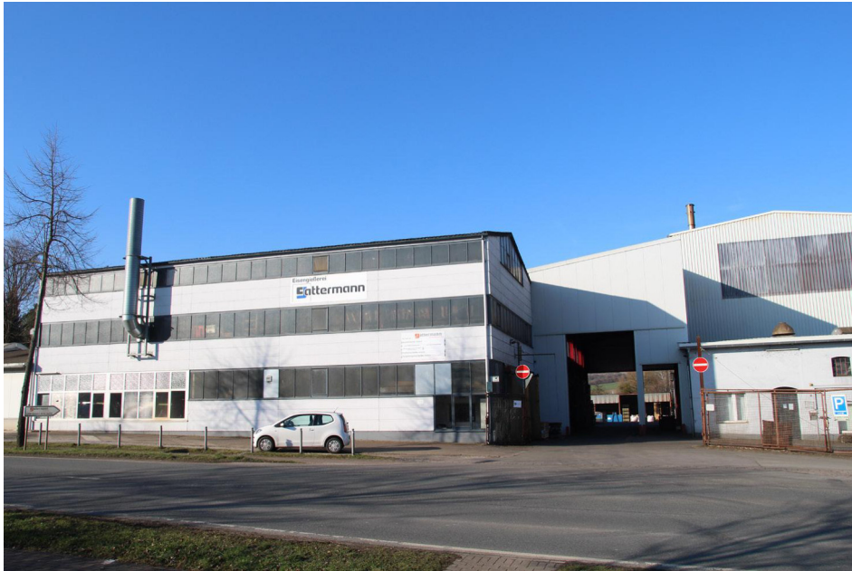
Abb. 84: Eisengießerei am Nonnensteg
