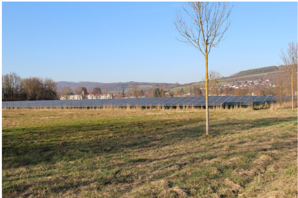
Abb. 49: Freiflächenphotovoltaik-Anlage bei Dassel
