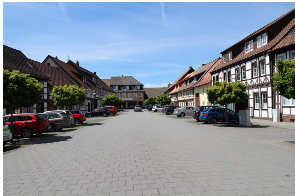
Abb. 30: Alter Markt Markoldendorf nach Durchführung der Sanierungsmaßnahme Foto: NLG 2022
