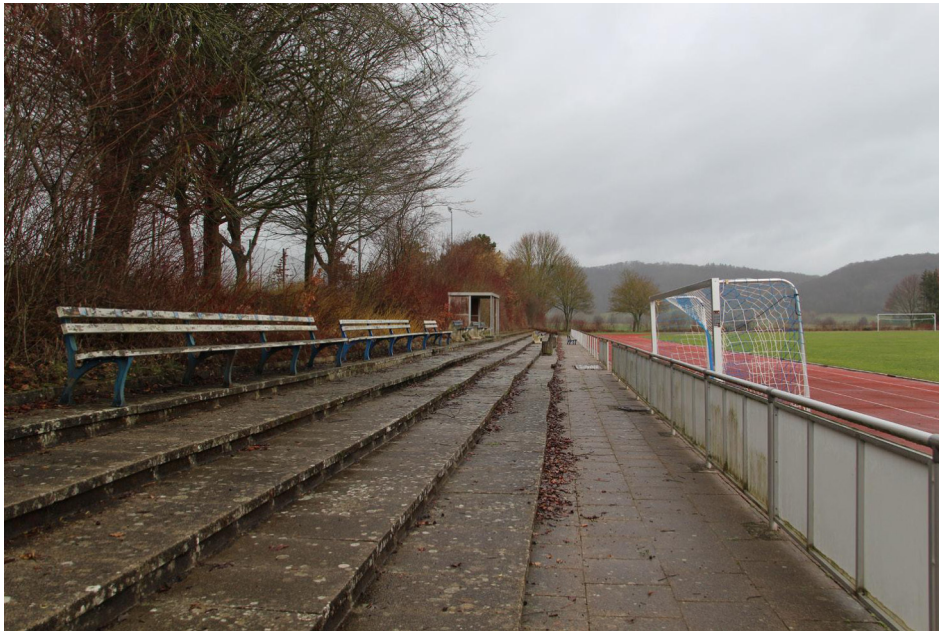
Abb. 88: Sicht auf den Tribünenbereich der Sportanlage
