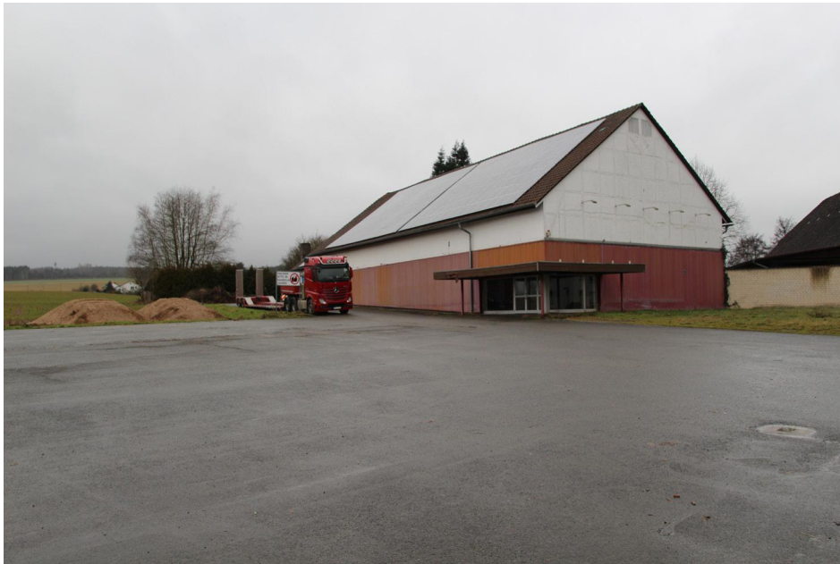
Abb. 80: Leerstehende Gewerbeimmobilie an dem Juliusburger Weg
