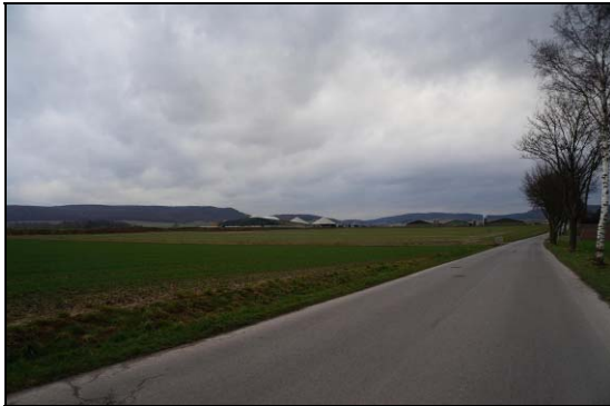
Blick von Süden auf die Biogasanlage
